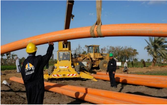
أعمال تركيب أنابيب الغاز الطبيعي
