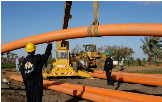
أعمال تركيب أنابيب الغاز الطبيعي
